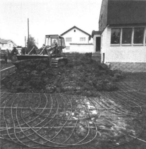
*Der Erdkollektor einer Wärmepumpenheizung besteht aus Kunststoffrohren, die im Erdreich in einem Meter Tiefe verlegt werden (Foto CTC).*
