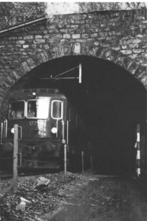
aufweist, also sozusagen eine Art «Lehrstück». Das ist die Strecke Kandergrund – Blausee – Mitholz. Dort hat es einen Tunnel von 697 m Länge, talseitig Betonstützmauern, auf Felsen abgestützte Lehenkonstruktionen und noch verschiedene weitere Bautypen.
