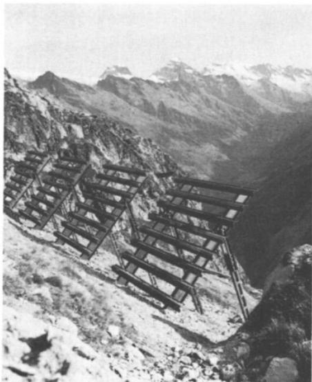
*Aus Bahnschienen und Schwellen wurden Stützen errichtet, um die Faldumalp lawinensicher zu machen.*
