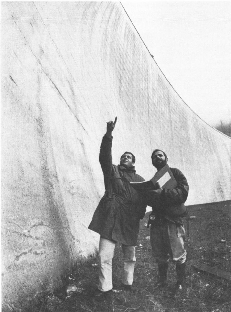
im Gelände in Beziehung gebracht. Millimetergenau lässt sich auf diese Weise die Verschiebung der Mauer feststellen.
