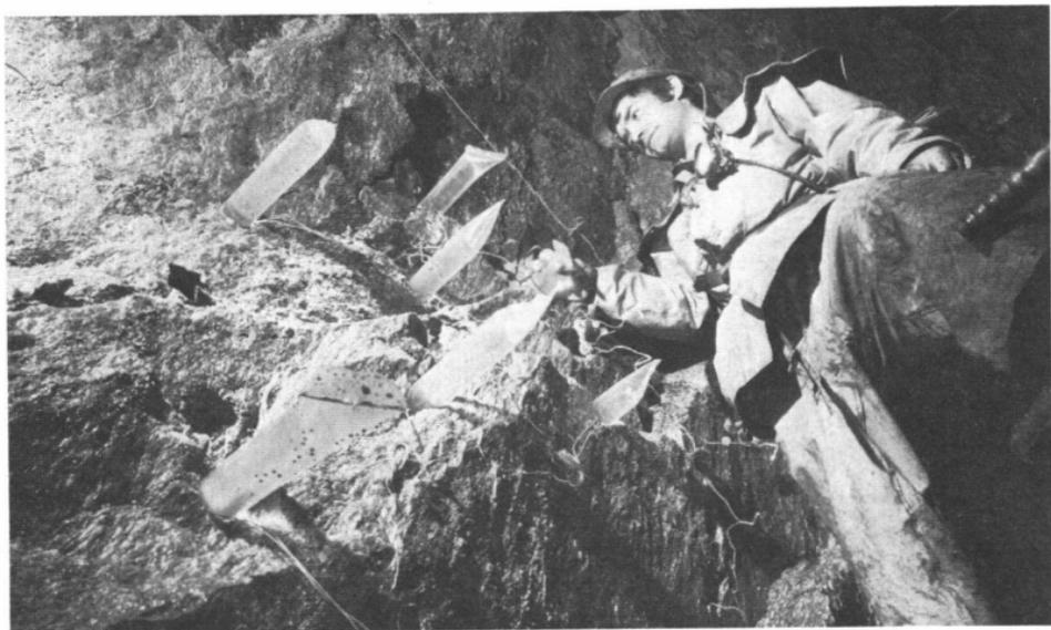
Solche Lasergeräte wurden in unserem Land erstmals vor fünf Jahren im Tunnelbau eingesetzt. Gegenwärtig fressen sich die «Jumbos», riesige Bohrmaschinen, sieben bis acht Meter im Tag ins Berginnere vor. Die Ungetüme treiben jeweils 100 Bohrlöcher von je 3,5 Meter Länge in den Fels. Diese Löcher werden mit Sprengstoff gefüllt, worauf Menschen und Maschinen sich zurückziehen. Nach der Detonation wird das ausgebrochene Material weggeschafft.
