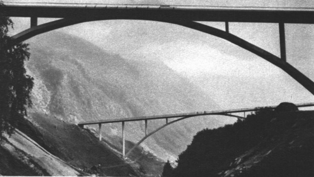
zum Bernhardintunnel führenden N 13 in der Steilstufe oberhalb Mesocco bedingte den Bau dieser beiden eleganten Bogenbrücken von 173 und 192 m Länge. Bogenbrücken in Eisenbeton werden seltener gebaut, seitdem durch die Vorspannung des Betons mit Stahlkabeln der Bau von schlanken Balkenbrücken mit grossen Stützweiten möglich ist. Bei hohen Talübergängen jedoch, wie hier auf der Südrampe des Bernhardins, ist der Bau der klassischen Bogenbrücke noch immer zweckmässig.
