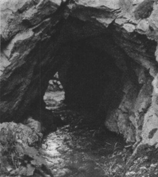
Die beiden Bilder zeigen die Wasserfuhre von Saxon im Unterwallis. Sie mißt gegen 30 km und führt teilweise durch Tunnels. Das obere Bild zeigt einen kurzen Tunnel, das untere einen in den Fels gesprengten Graben.
