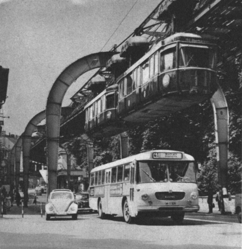
*Auf 2,8 km Länge fährt die Wuppertaler Schwebebahn in 8 m Schienenhöhe über Straßen (über der Wupper in 12 m Höhe). 1 km dieser Bahn kam beim Bau auf 1 Million Mark zu stehen; 1 km Untergrundbahn hätte 4–6 Millionen gekostet.*
