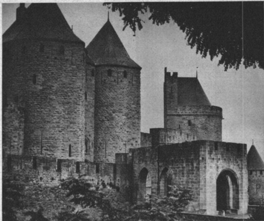
*Wie stark die Stadttore geschützt waren, zeigt dieses Bild. Der Zugang führt über einen Burggraben mit einer Zugbrücke (auf dem Bild nicht sichtbar), dann in einen kleinen Hof und hierauf zum eigentlichen Tor mit den zwei wuchtigen Türmen links und rechts. – Die innere Ringmauer ist stellenweise 4 m dick.*
