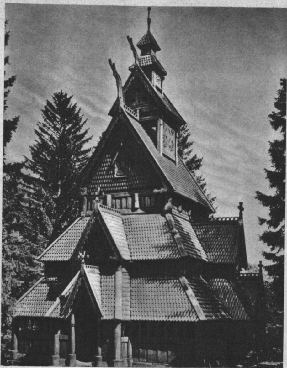
*Die Gol-Stabkirche im Freilichtmuseum auf der Halbinsel Bygdøy bei Oslo, der Hauptstadt von Norwegen. Starke, hohe Masten („Stäbe“), die vom Boden bis zum obersten Dach hinaufreichen, geben dem ganzen Bau Halt und Stütze. Das unterste Dach deckt den sogenannten Umgang, das zweite die Seitenschiffe der Kirche, das dritte (mit einem Glockentürmchen) das Hauptschiff.*
