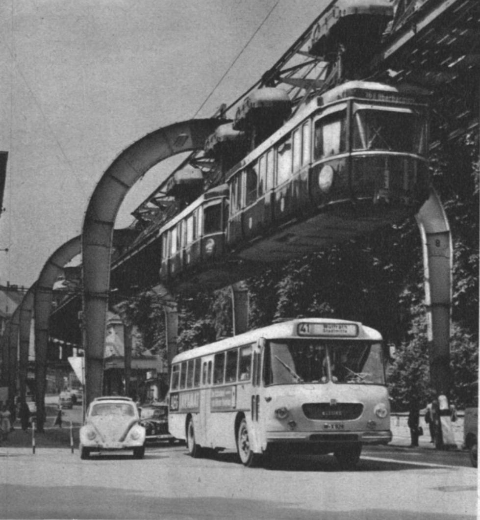
*Auf 2,8 km Länge fährt die Wuppertaler Schwebebahn in 8 m Schienenhöhe über Straßen (über der Wupper in 12 m Höhe). 1 km dieser Bahn kam beim Bau auf 1 Million Mark zu stehen; 1 km Untergrundbahn hätte 4–6 Millionen gekostet.*
