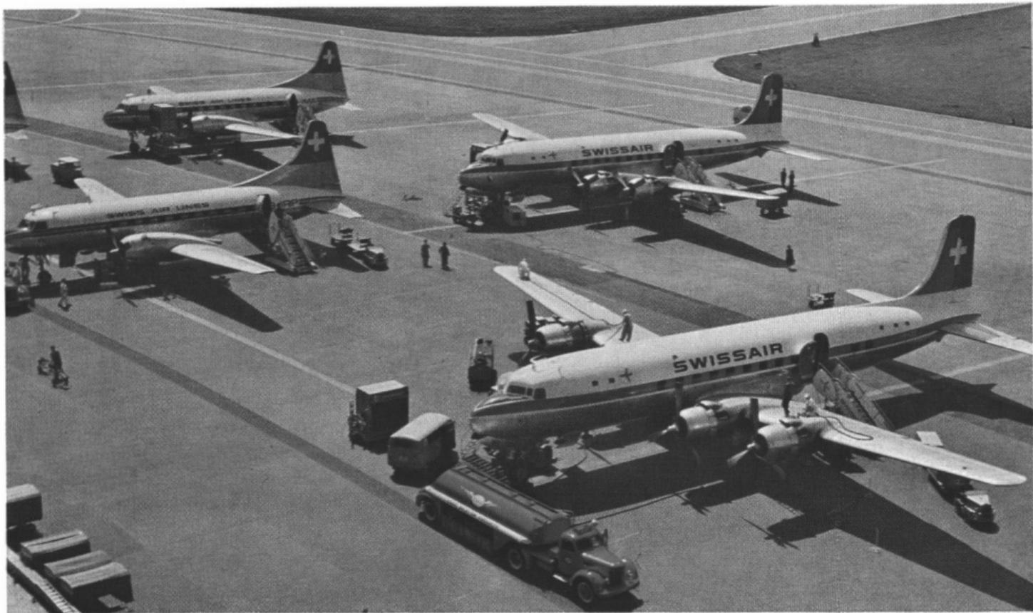
Flugzeuge werden in Kloten mit Benzin, Motorenöl usw. versorgt. Große Flugzeuge benötigen bis 2000 und mehr Liter Benzin pro Flugstunde. Der lange, rote Tankwagen faßt 10000 Liter. (Photo Swissair)
