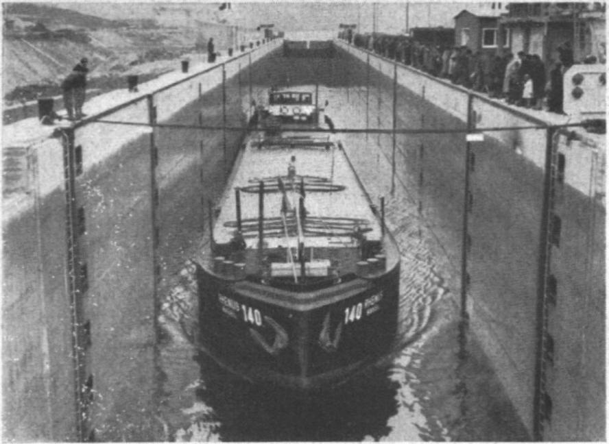
**Die 180 m lange, 12 m breite und 8 m hohe Schleusenammer der Schiffsschleuse in Birsfelden bei Basel. Die Durchschleusung dauert, je nach dem Wasserstand, für die Bergfahrt 33–35, für die Talfahrt 22–25 Minuten.**
