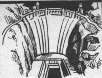
Der Hoover-Damm am Colorado-Fluss in den U.S.A. ist der höchste Staudamm der Welt (223 m hoch, Wäggital 100m, Grimsel 107m) Dixence wird 284m hoch!
