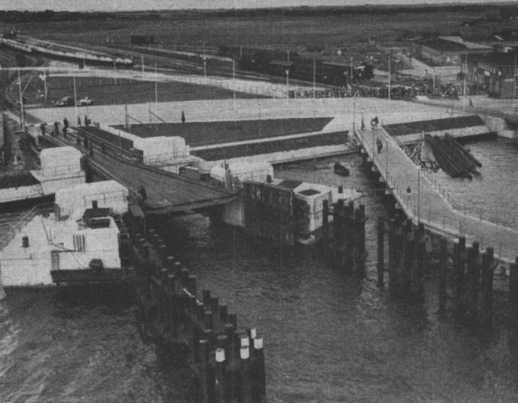
**Diese Stützen im Wasser leiten das Fährschiff so, daß die Geleiseanschlüsse von Land und Schiff genau zusammenpassen.**
