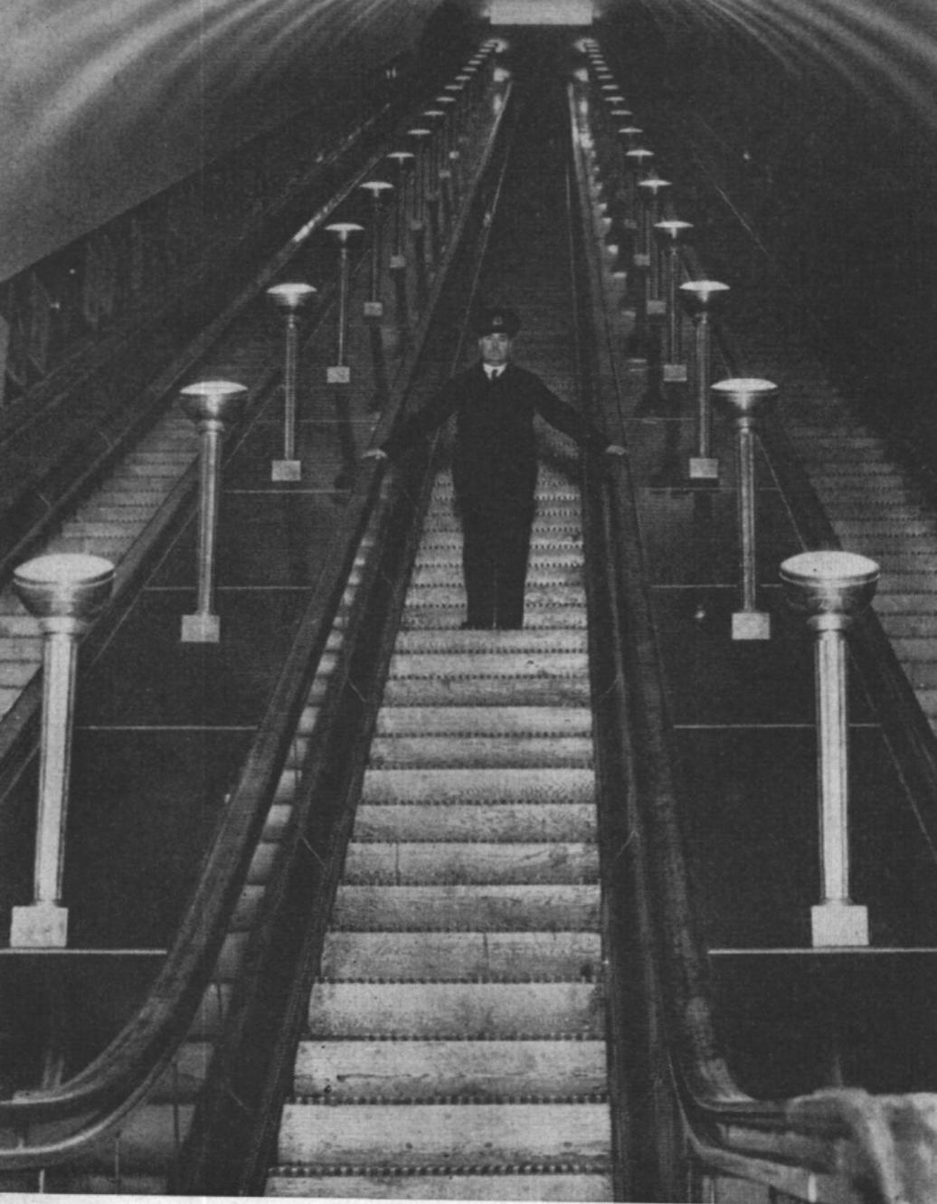
**Die längste Rolltreppe der Welt.** Sie befindet sich in einer Station der Untergrundbahn in London und zählt 304 Stufen bei einer Treppenlänge von rund 60 m. Insgesamt gibt es 181 Rolltreppen in Londoner Untergrundstationen.
