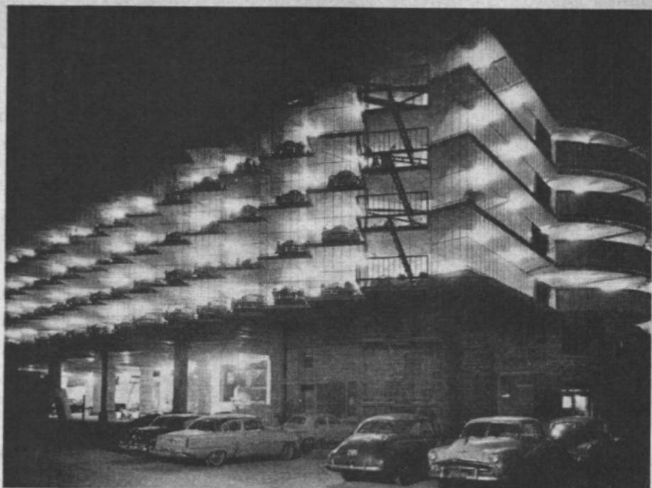
**Die fast nur aus Glas und Stahl gebaute Garage bei nächtlicher Beleuchtung.** Wegen der zickzackförmigen Front können die Wagen sehr gut schräg parkiert werden, wodurch mehr Wagen Platz finden.
