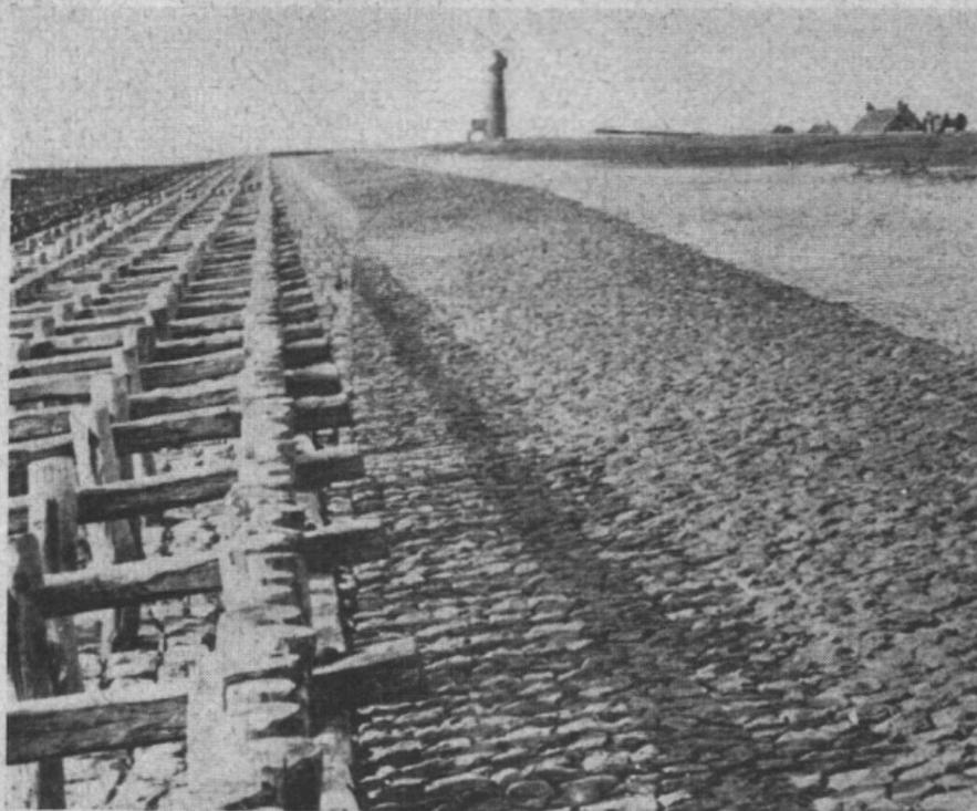
**Mit den senkrecht eingerammten Basaltsäulen werden die holländischen Deiche (Dämme) wirksam gegen den Wellenschlag geschützt.**
