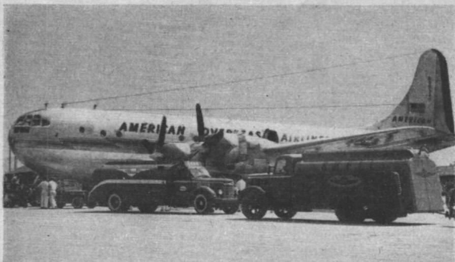
Tankwagen versorgen eine amerikanische Maschine mit Benzin und Oel. Vor dem Amerikaflug tankt unsere DC 4 13 500 Liter Benzin, muss aber auf einem der 3 Zwischenhalte noch Benzin nachfüllen.
