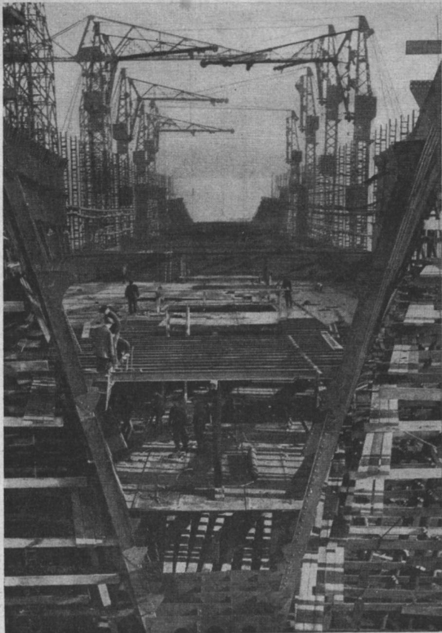
**Auf dieser und der nächsten Seite zeigen uns Bilder etwas vom Bau solcher Riesendampfer. Hier sehen wir, wie die Böden zu 3 Zwischendecks erstellt werden. Riesige Krane müssen die Eisenplatten, Balken, Bretter usw. zu den Baustellen emporheben.**
