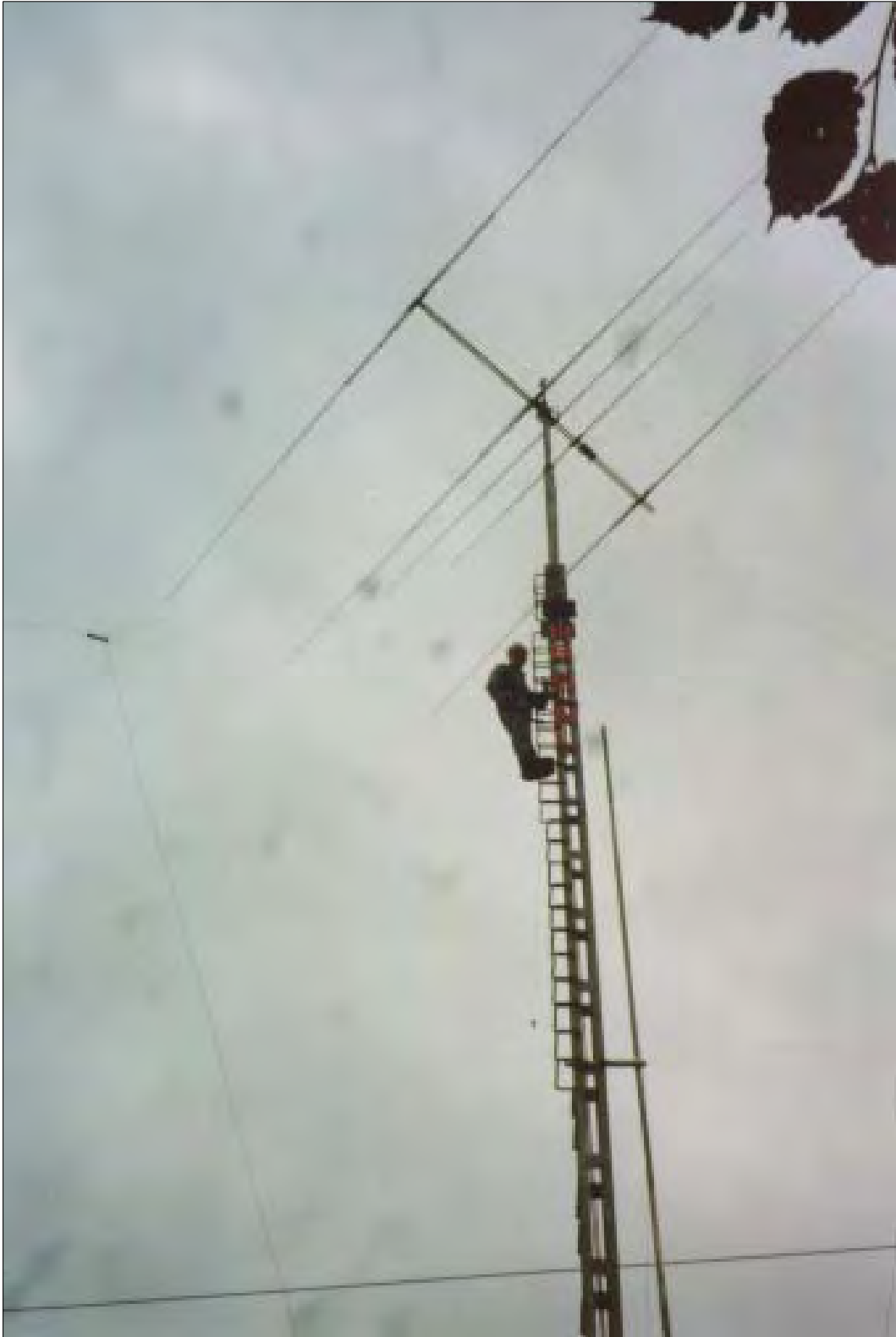
30. Nov. 1995: Shuntfeed entfernen. 6 neue Umbrelladrähte installieren. HB9NL bald 72 jährig.
