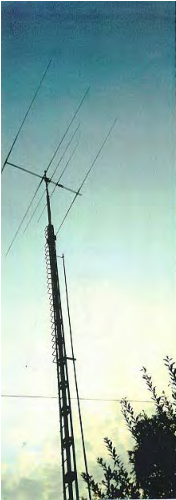
Yagi auf 3 Elemente verkürzt und mit Shuntspeisung aus 20mm Aluminium-Rohr ausgerüstet
